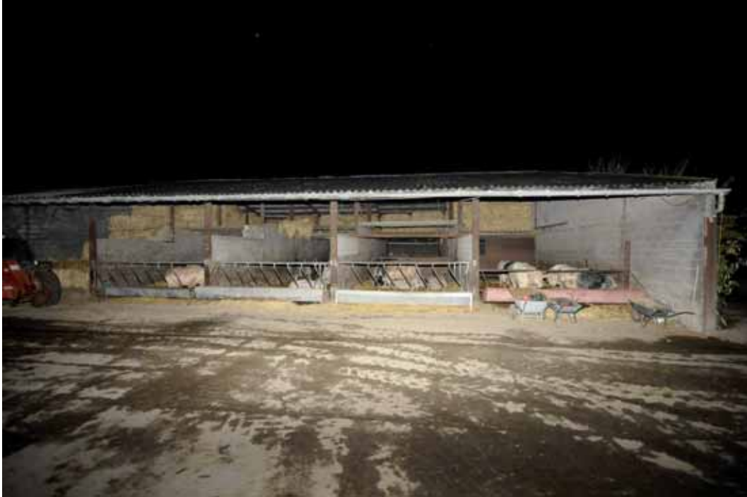
Figuur 2. De stallen van een veehouder in Widooie werden twee maal onderzocht in de hoop de tweede nacht alsnog een Ingekorven vleermuis in het gebied van de Natuurverbindingzone Heers-Tongeren aan te treffen. De netten werden voor de gehele opening, onder de dakgoot gezet en ook bij de deuren aan de zijkant van de stal.
